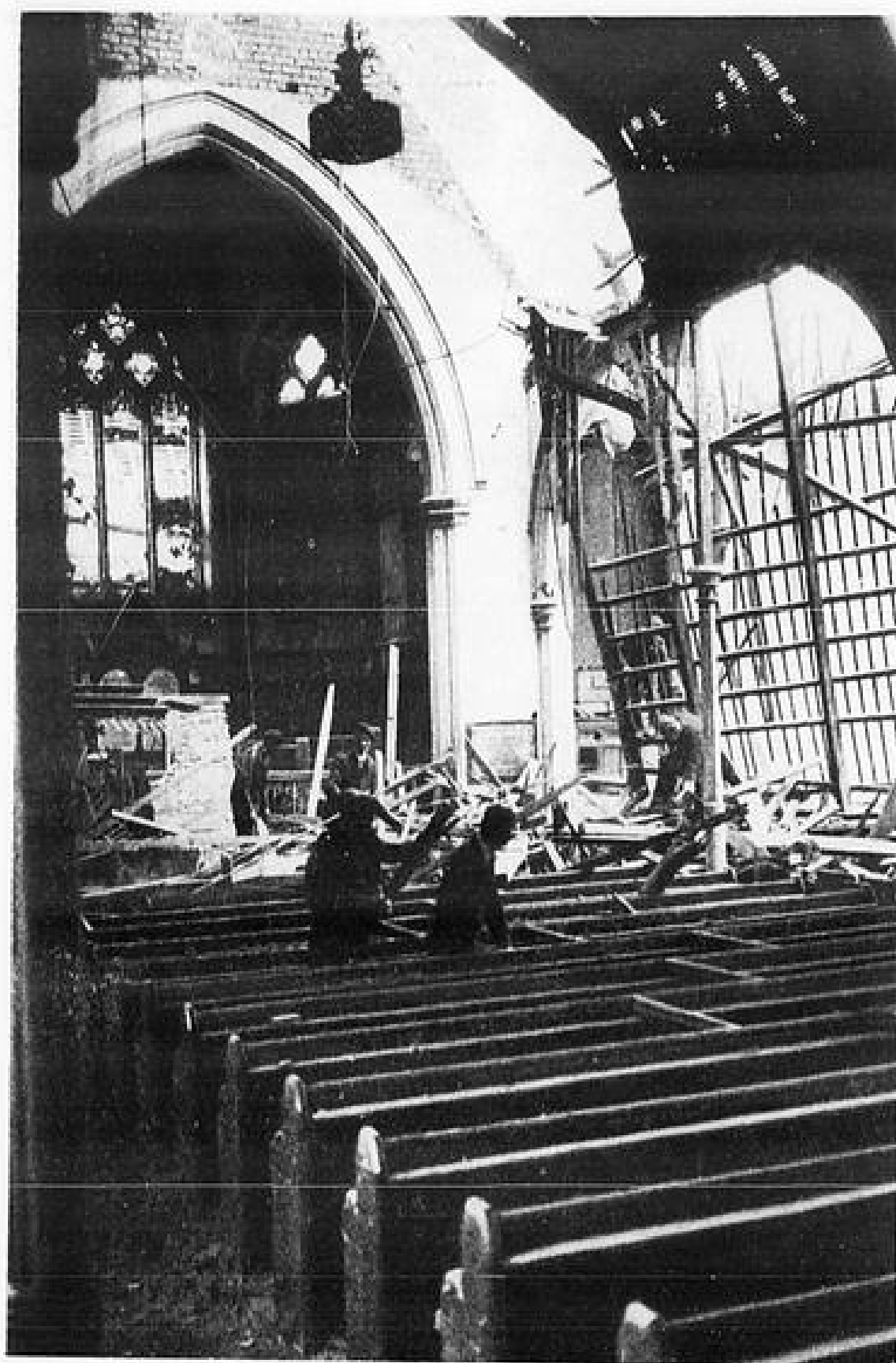
Interior de uma Igreja numa cidade do Sudeste da Inglaterra, danificada por bombas nazistas
