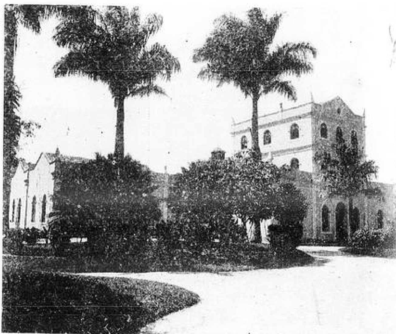
Aprendizado Agrícola Floriano Peixoto — Estado de Alagoas — Edifício da sede.
