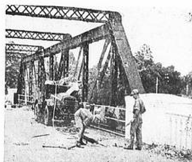
Sapadores e mineiros indianos quando minavam uma ponte perto de Kuala Lumpur.
