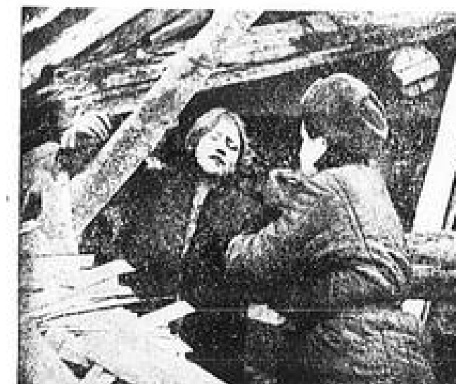
Retirando uma senhora ferida na sua residência derrubada por bombas nazistas.
