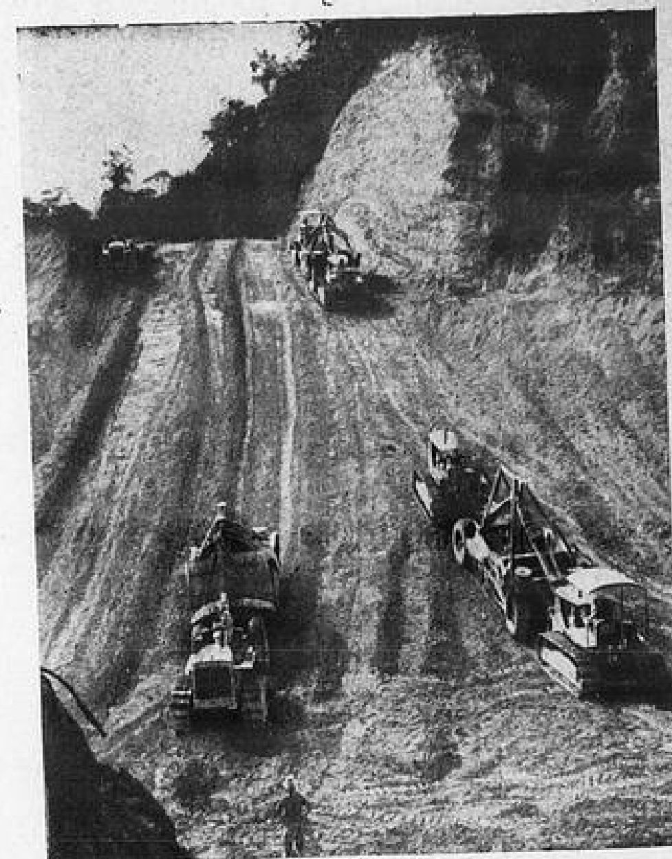
Aspecto dos trabalhos da Rodovia Panamericana em construção.
