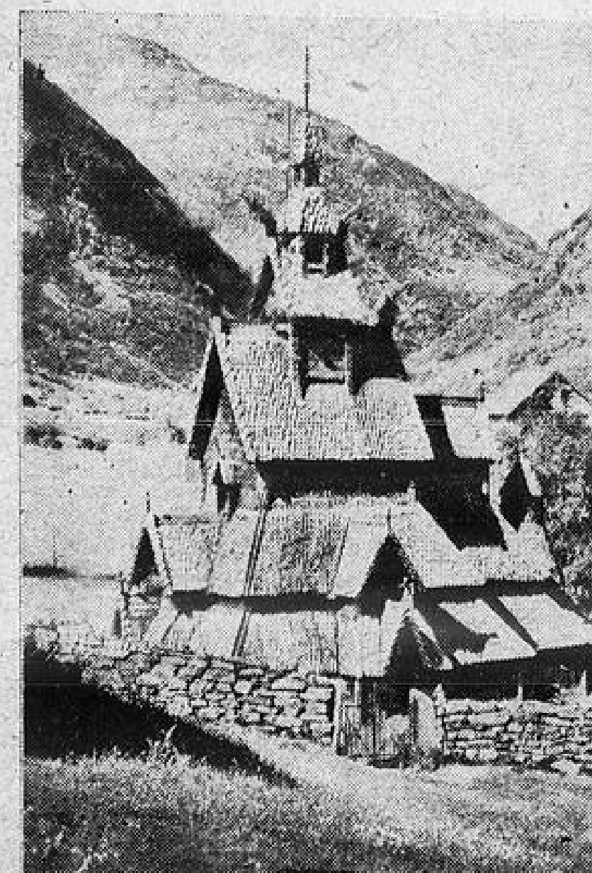
Igreja norueguesa do século XIII, construção de madeira.
