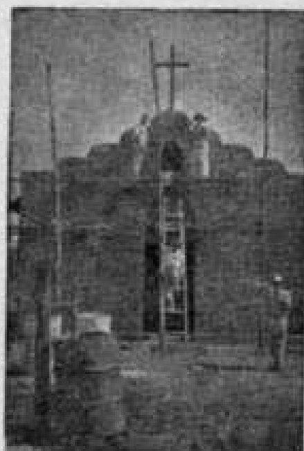
A Igreja Paroquial, de Douradoquara, em construção
